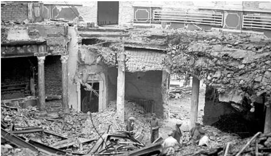
→ Nach der Zerstörung in der Reichspogromnacht im Jahr 1938 waren von der Synagoge aus dem Jahr 1912 nur noch Ruinen übrig geblieben
